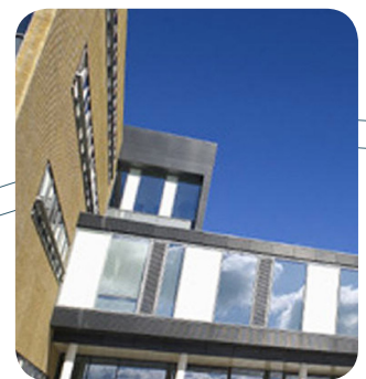
Forsyningsvirksomhederne Aalborg Kommunes administrations-bygning på Sigsborg Brygge Foto: Baghuset pressefoto
